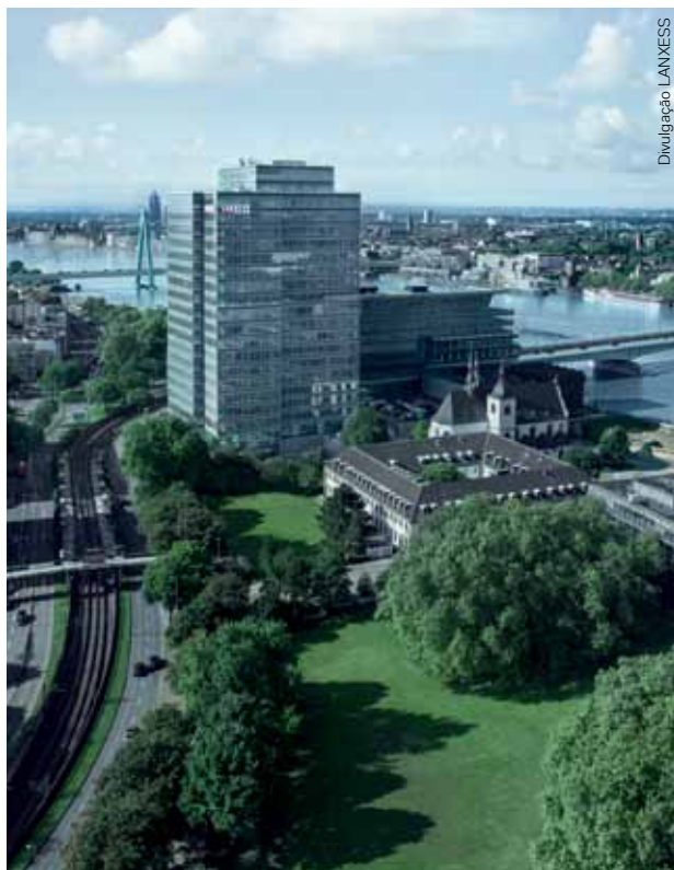
Fachada da LANXESS Tower em Colônia, cidade reconhecida pela excelência em pesquisa acadêmica e infraestrutura de ponta
