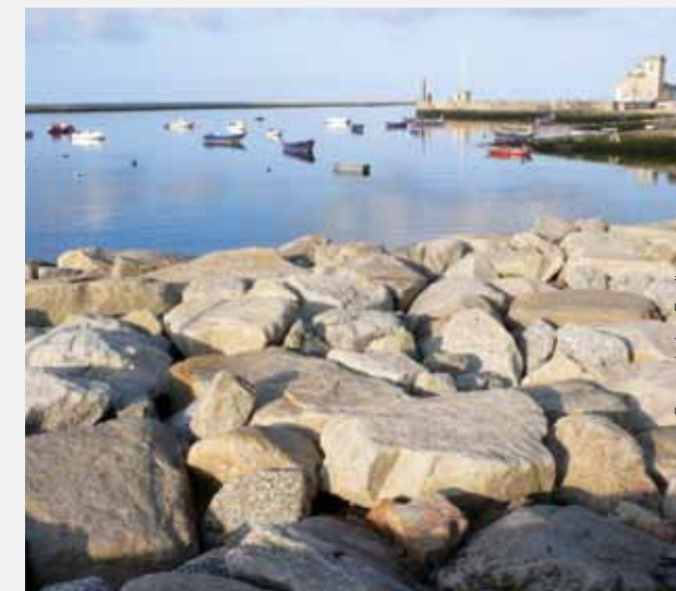
Represa da Cantareira (SP): à beira do colapso
